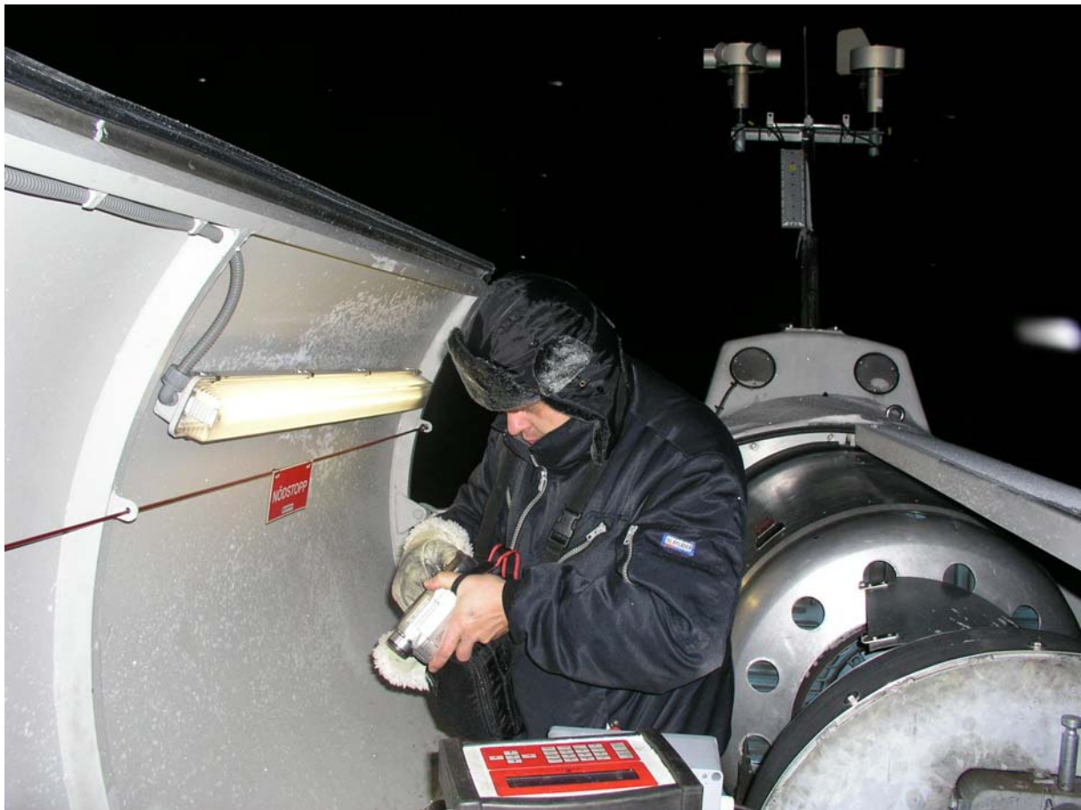
Figur 2 Installation pågår. Det är kallt.
